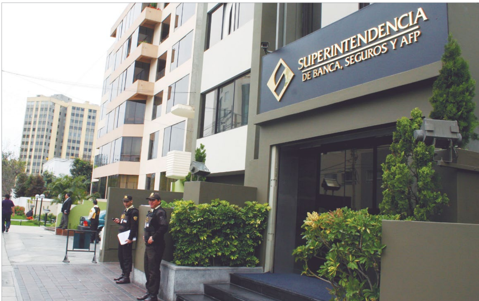
Sede principal de la Superintendencia de Banca, Seguros y AFP, ubicada en la calle Los Laureles en el distrito de San Isidro.
