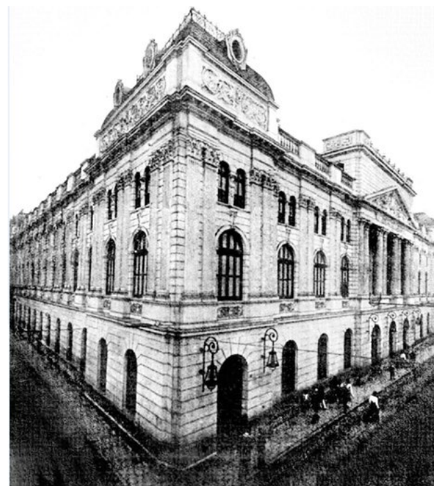
Primer local de la Superintendencia de Banca y Seguros, ubicado en el Centro de Lima.
